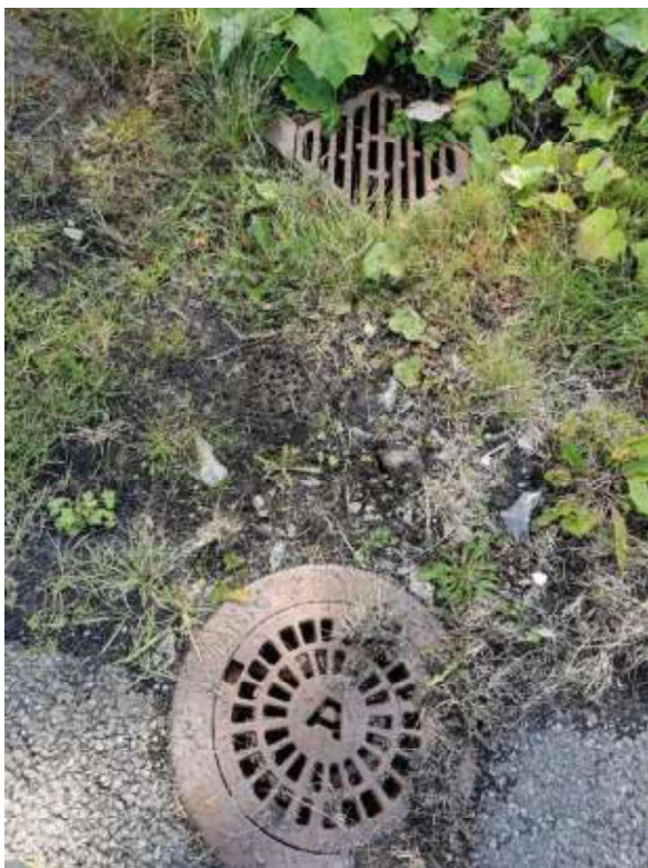
Bilde 7: Ny sluk er montert ved sandfangkummen utenfor nordre langside. Ingen bedring for vanntilsiget
