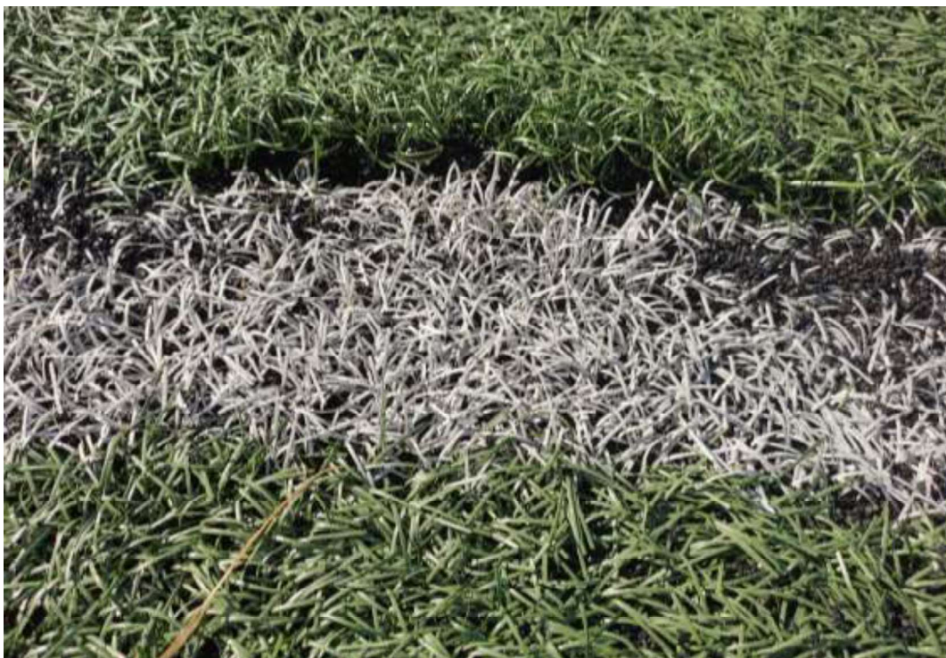
Bilde 5: Løs linje er registrert i vestre målfelt. Må limes umiddelbart.
