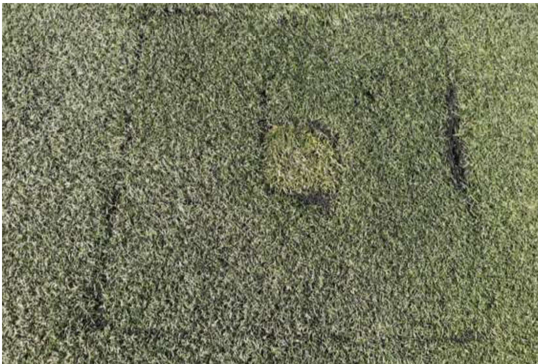
Bilde 6: Det er en løs flik på utskiftet gress i området for østre straffemerke. Bør limes snarest
